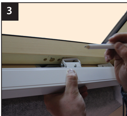
3 Приложите привод к центру рамы окна и отметьте расположение кронштейнов и держателя цепи.
