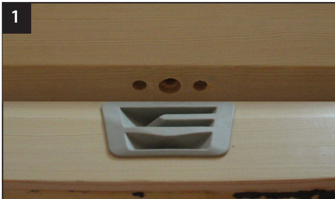
1 Плотнo закройте окно и снимите нижнюю ручку.
