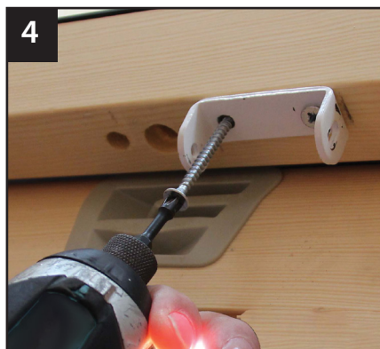
4 Закрепите держатель цепи на створке.
